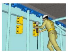
桁下でスプリットTの設置。 合成桁の場合、仮設部材も設置
